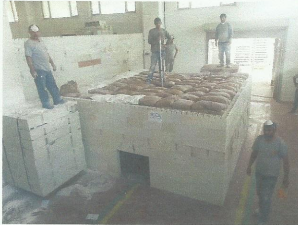
Resim 4. 800 kg/m 2 Bina döşeme yüklemesinden görünüş.
