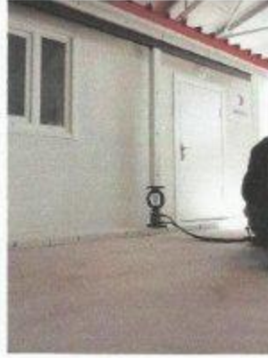
Resim 1b. Bina saçak yüklemesinden görünüş.
