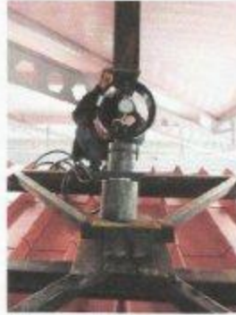
Resim 1c. Bina çatı yüklemesinden görünüş.
