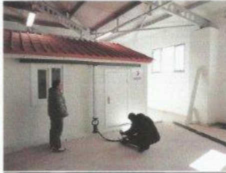
Resim 1a. Bina saçak yüklemesinden görüntü.
