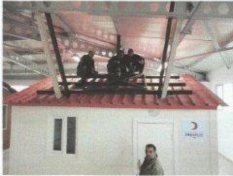
Resim 1a. Bina çatı yüklemesinden görünüş.
